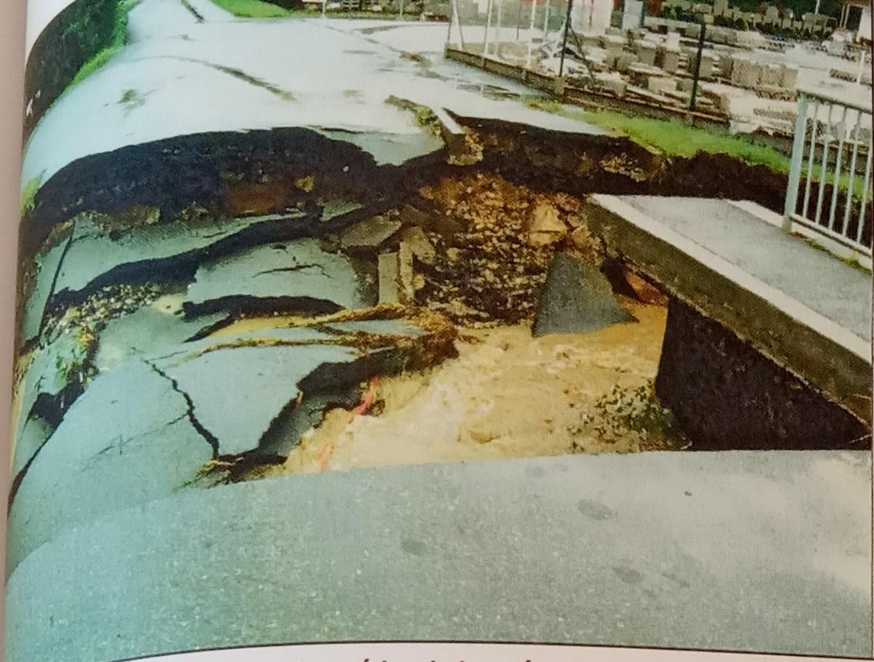
zničený most na silnici vedoucí k vlakovému nádraží a část odplaveného areálu Beton Těšovice
